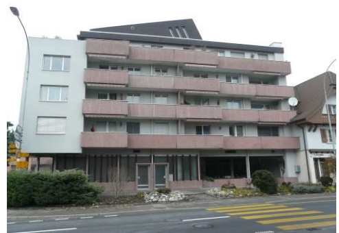
Abb. 33: Teilansicht eines wuchtigen Gebäudekomplexes (Parz. Nr. 20)
