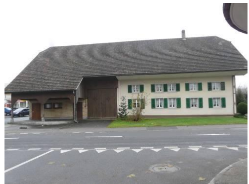
Abb. 28: Landwirtschaftliches Wohngebäude, Parzelle Nr. 60, Ansicht von Schlosserstrasse
