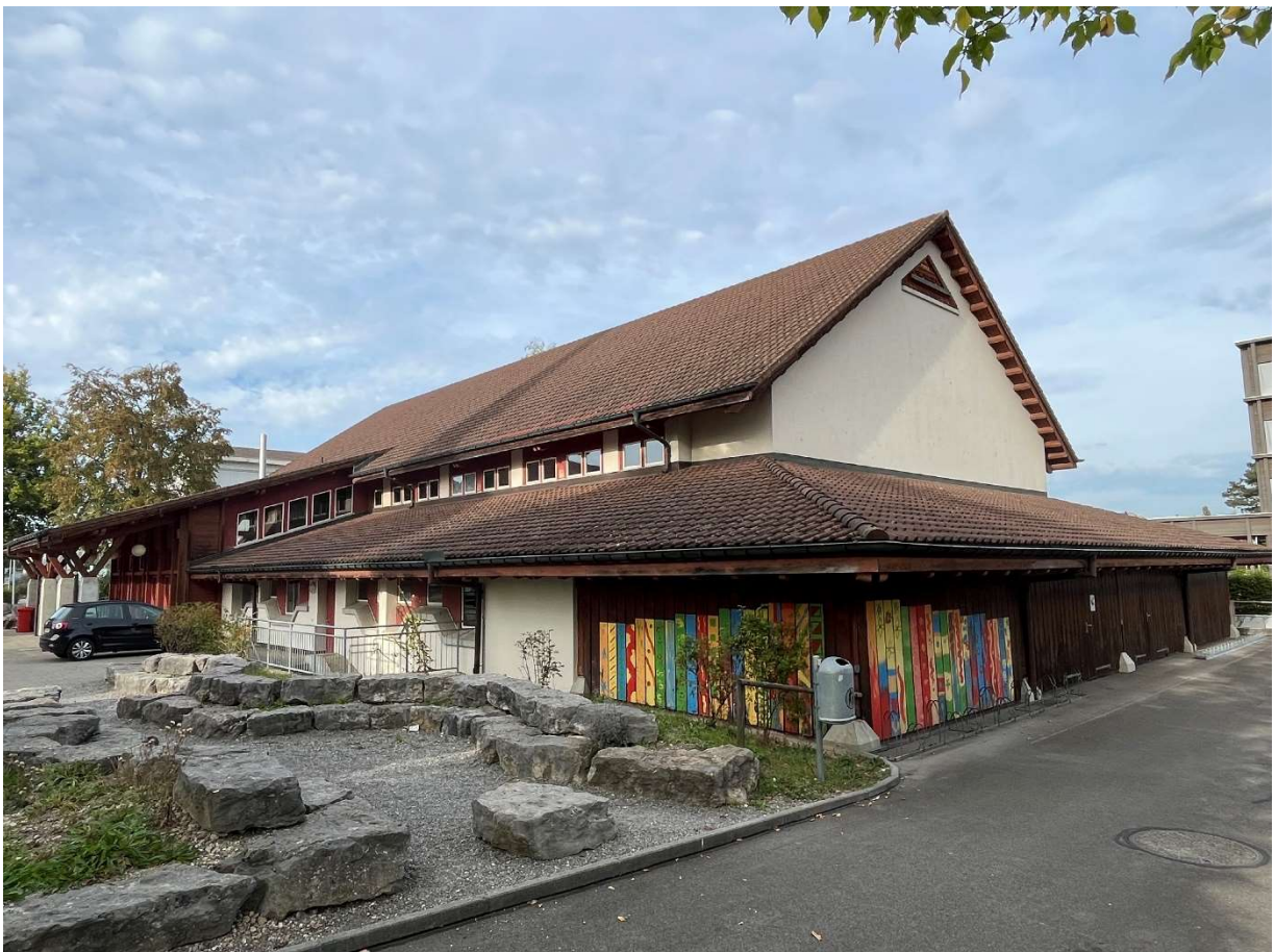
Schulhaus Hofmatt, Schötz
