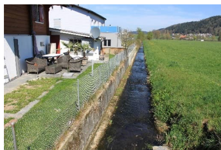
Abb. 34: Sämtbach, Blickrichtung Norden
