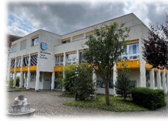
Neubau / Sanierung Gemeindehaus
