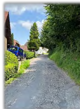
Sanierung und Perimeter Hübelistrasse
